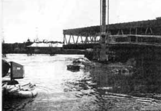
Inundación. Una riada del Arga en plena obra de construcción del Molino de Caparrosa derivó en un pleito entre constructora y la administración por el sobrecoste que supuso para el proyecto. CEDIDA
