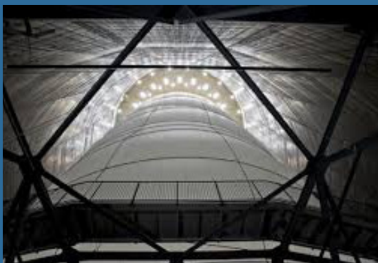
Gasómetro de Oberhausen
