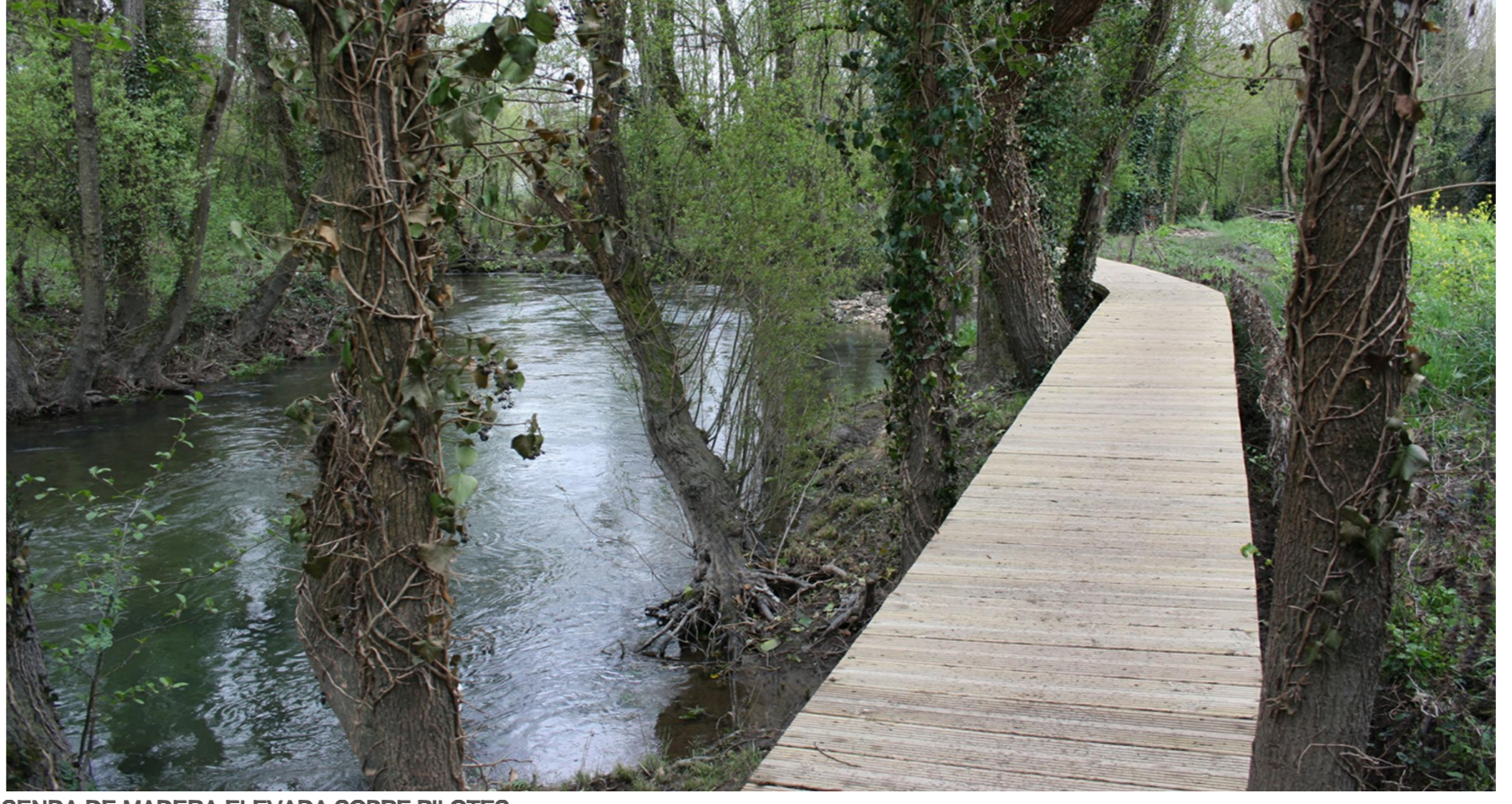
SENDA DE MADERA ELEVADA SOBRE PILOTES
