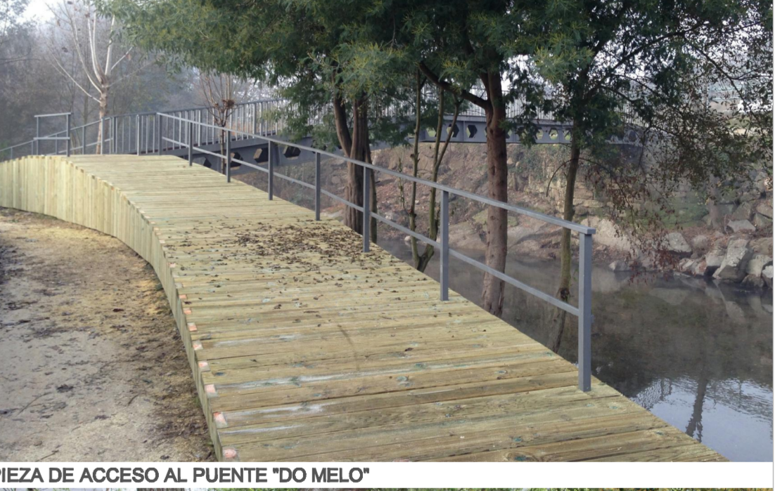
PIEZA DE ACCESO AL PUENTE "DO MELO"
