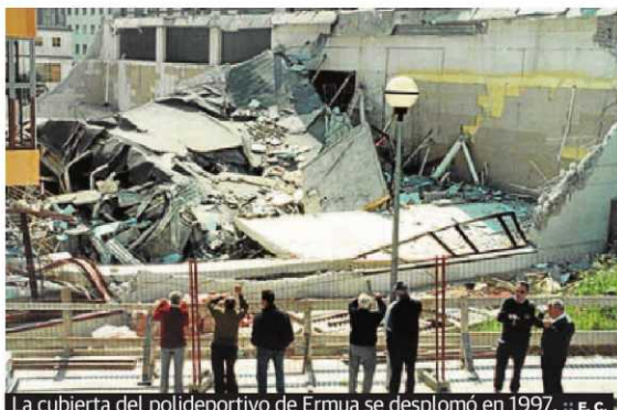
La cubierta del polideportivo de Ermua se desplomó en 1997. :: E. C.
