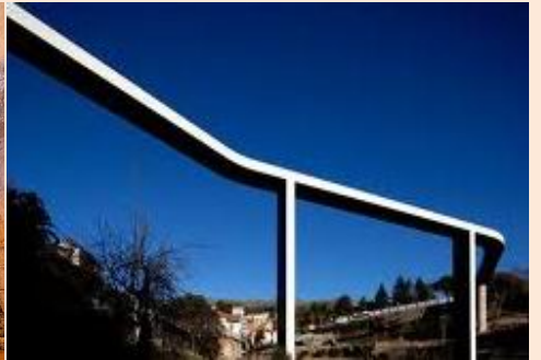
Pasarela de João Luís Carrilho
