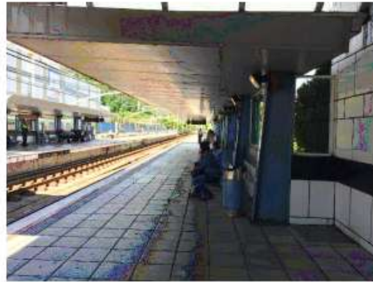
Marquesina Etxebarri. Pilares laterales
