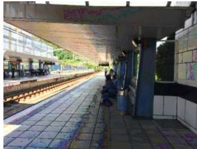
Marquesina Etxebarri. Pilares laterales
