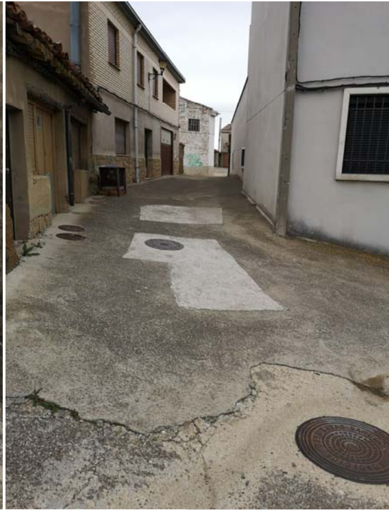
Red de saneamiento obsoleta
