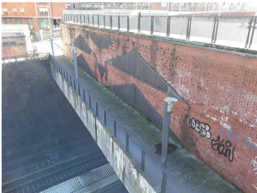
*Vistas hacia muro lateral este: arranque losa cubrimiento con muro exterior de parking con rejillas triangulares para ventilación natural*
