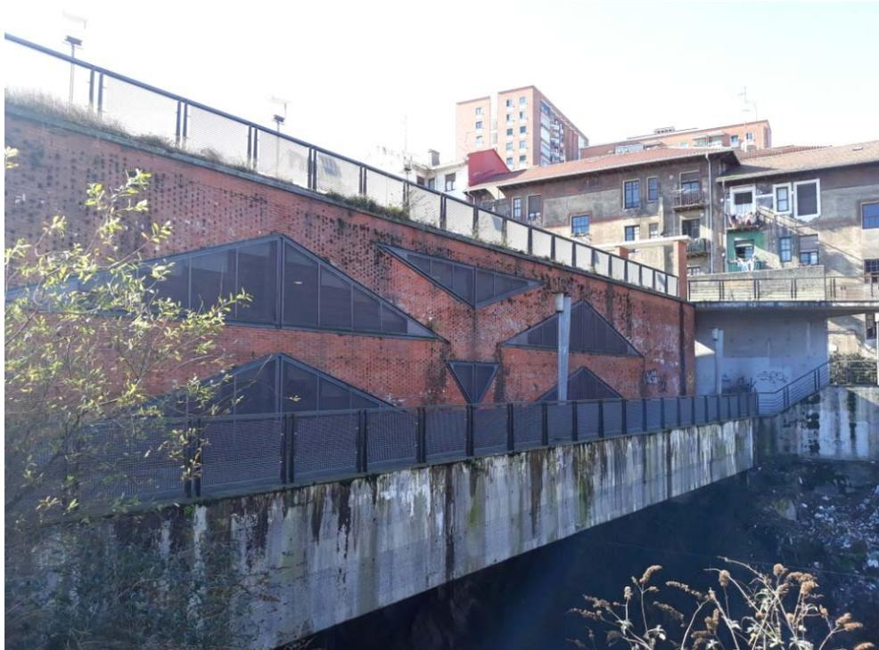
*Vista hacia muro lateral oeste: arranque losa cubrimiento con muro exterior de parking con rejillas para ventilación natural.*
