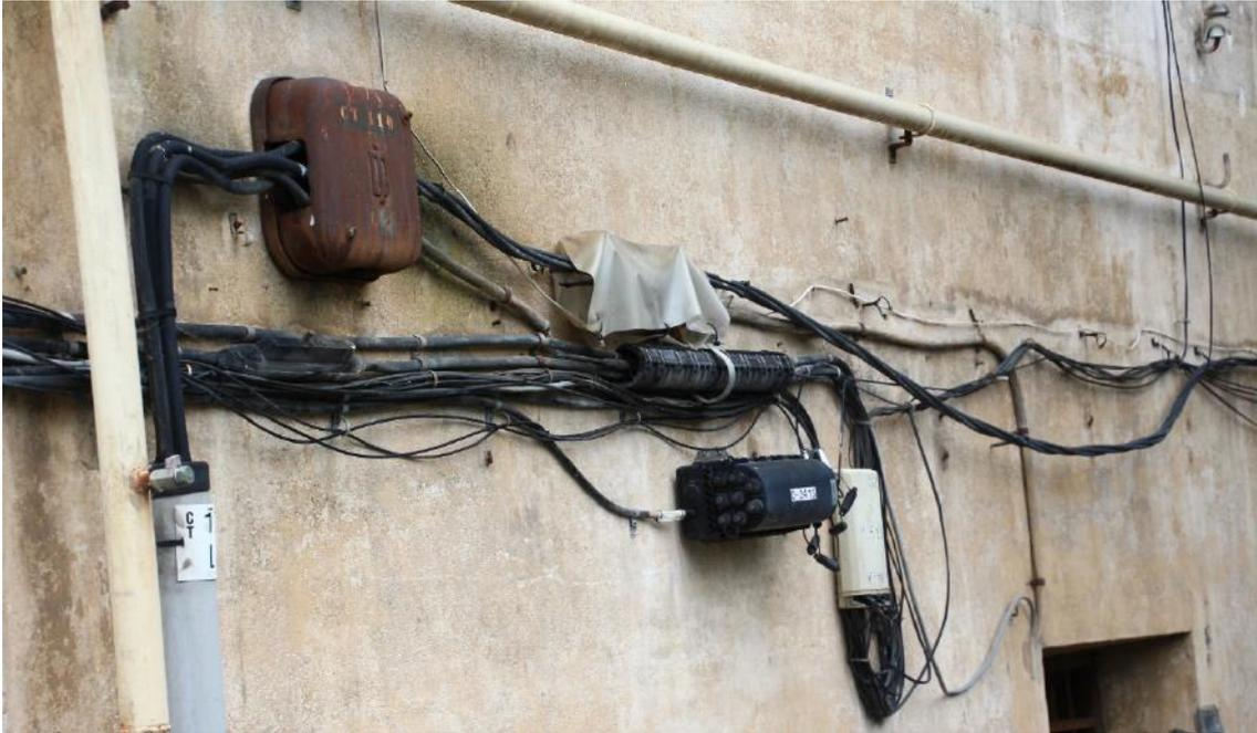
Derivación Eléctrica a portal y montante y montante de abastecimiento de agua por roza en fachada
