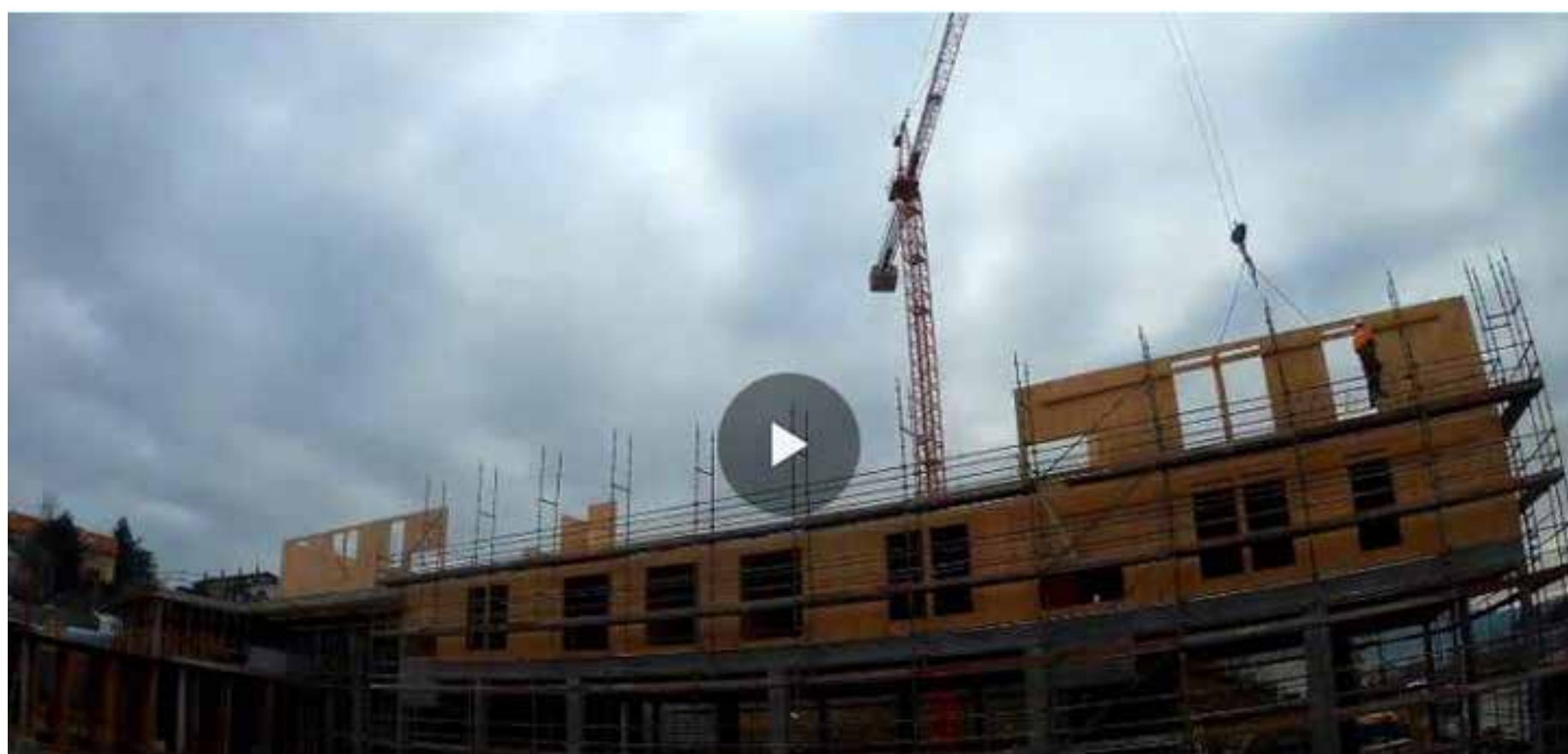
Muntaiaren zati baten bideoa Vídeo de parte del montaje de la estructura
