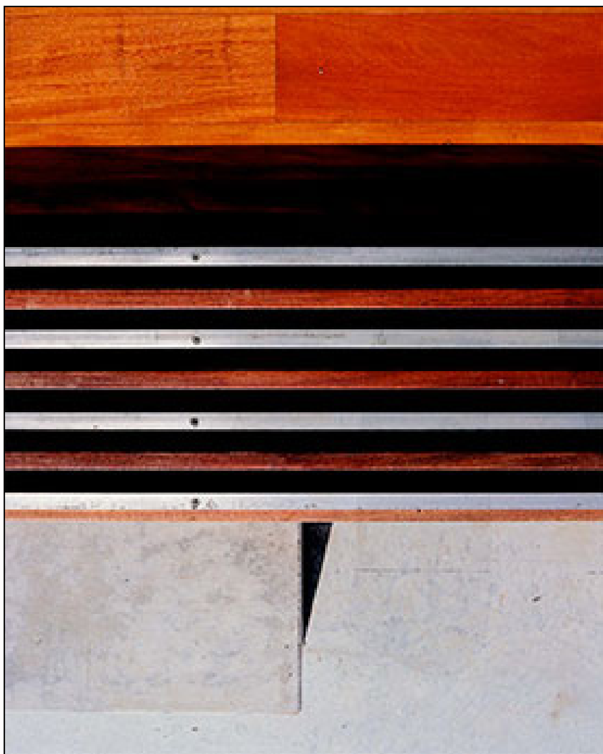
Viana do Castelo. Casa en Paçô Carreço. 1997. Detalle de la carpintería
