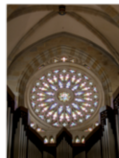
Bosetón neogótico sobre el acceso principal de la fachada Oeste.
