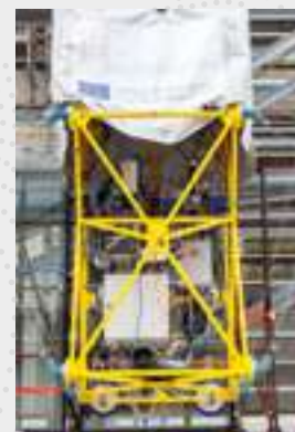
03 Detalle de la estructura en la que se alojan los sistemas de manipulación para la colocación de los anclajes y para el movimiento del robot.
