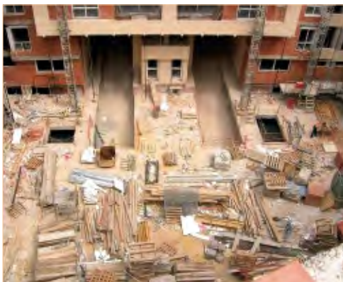
Figura 1. Obra de Edificio de Viviendas, año 2006
