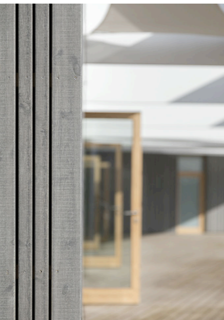
Fachada ventilada acabada en madera
