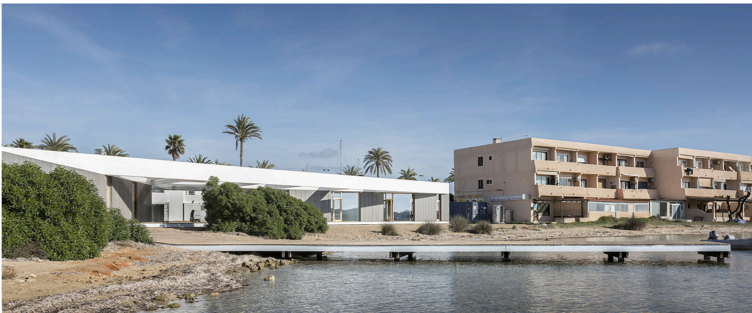
Pantalán integrado en la tarima exterior del edificio
