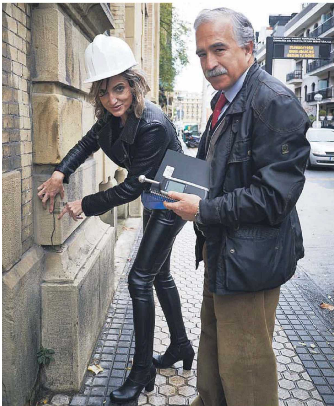
Olatz Etxeberria pone un testigo en una grieta en presencia de un miembro del colegio. :: usoz
