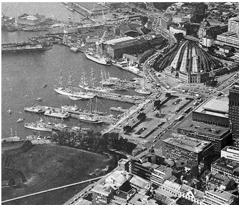
La bahía de Pipervika antes de la remodelación. Ferrocarril y autopistas separaban el puerto de la ciudad, que había olvidado el mar.
