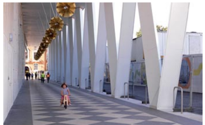
Luminarias, pavimentación y pilares de la Galería.
