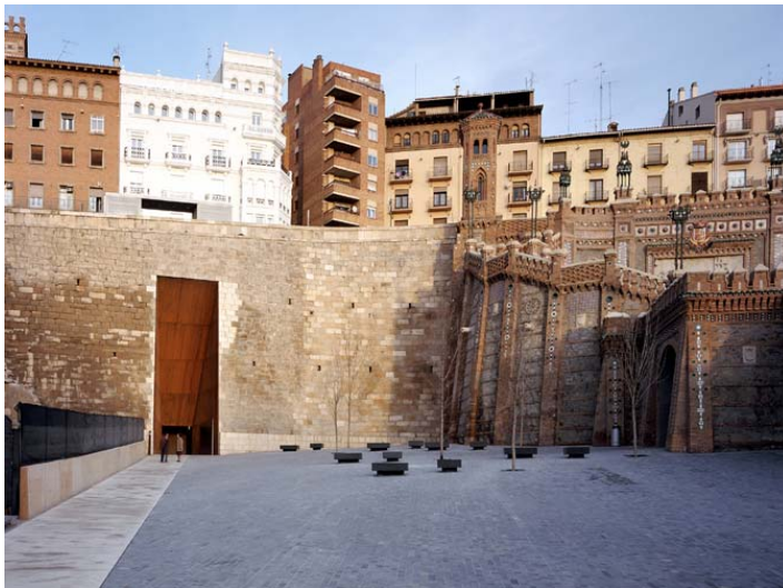
Imagen del acceso al ascensor.
