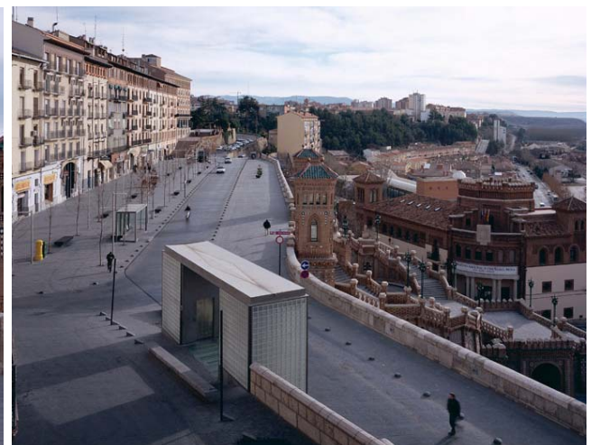
Imagen del acceso al ascensor.
