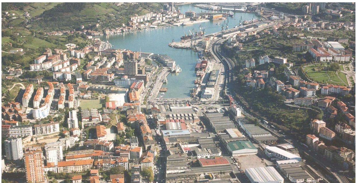
Imagen del Puerto de Pasaia con el área de La Herrera en primer término
