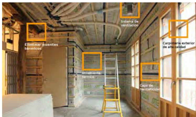
Imagen del proceso de la obra con algunos elementos básicos
