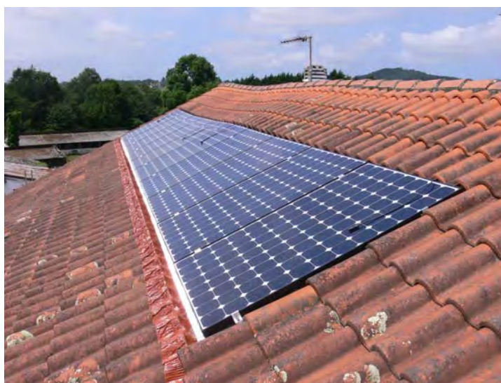
Imagen de los módulos fotovoltaicos
