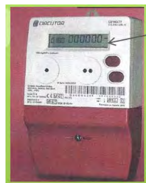
Contador eléctrico gestionado por el Ayuntamiento
