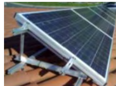
Solar fotovoltaica para cargar la pila de H 2
