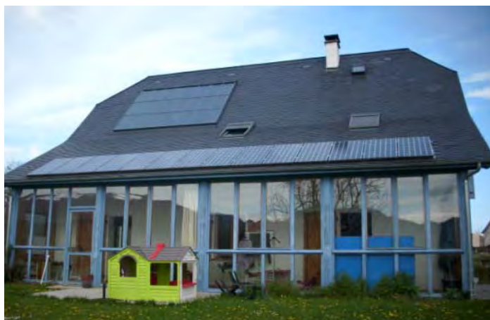
Invernadero, solar fotovoltaica (eléctrica) y solar térmica (térmica)
