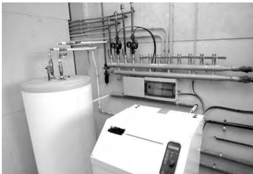
Bomba de calor de geotermia, polideportivo de Araia
