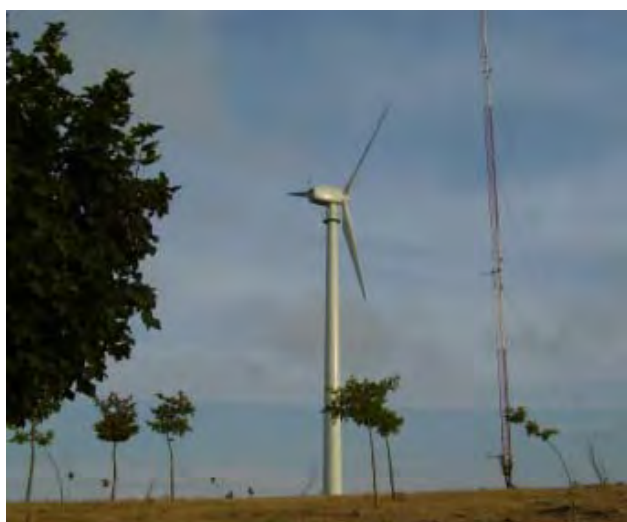
Vista del aerogenerador de 100KW
