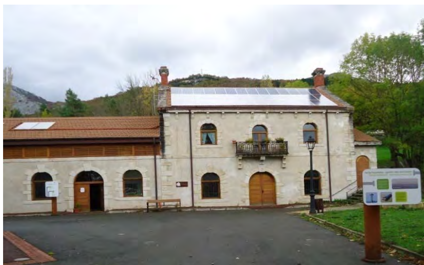
Central hidroeléctrica San Pedro de Araia
