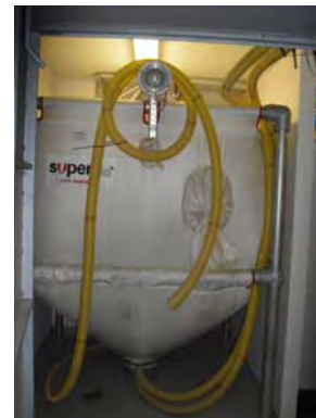
Silo flexible de pellets
