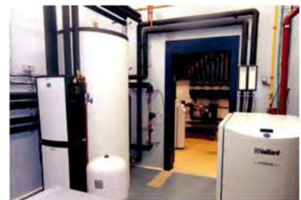
Sala de calderas
