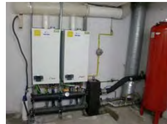
Dos calderas con gran modulación
