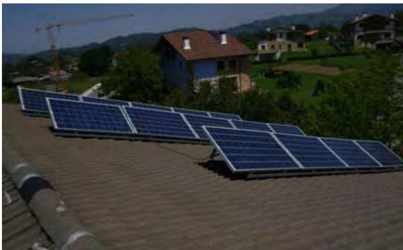
Imagen de los módulos fotovoltaicos
