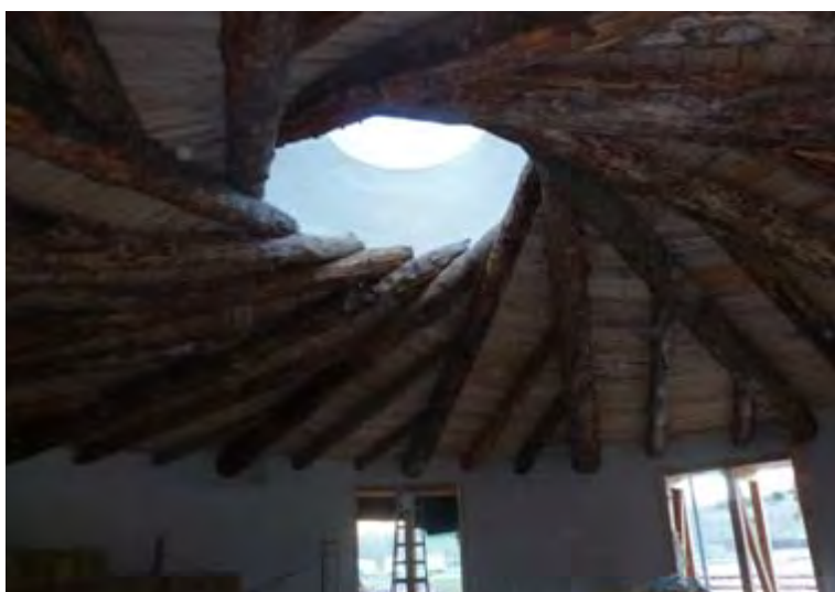
Vista interior de la cubierta
