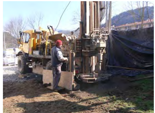
Realizando las perforaciones
