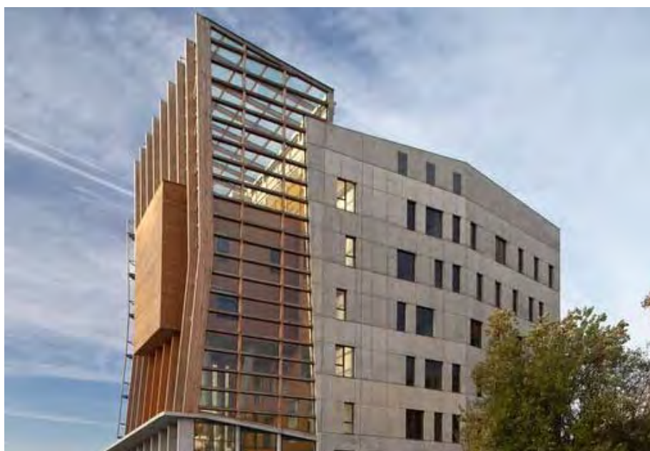
Imagen exterior del edificio Enertic (Imagen cedida por Cortizo)
