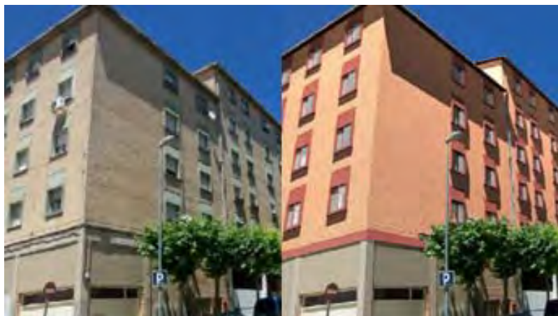
Vista de un edificio antes y después de ser rehabilitado
