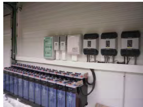
Cuadro de protecciones, reguladores, inversores y bancada de baterías
