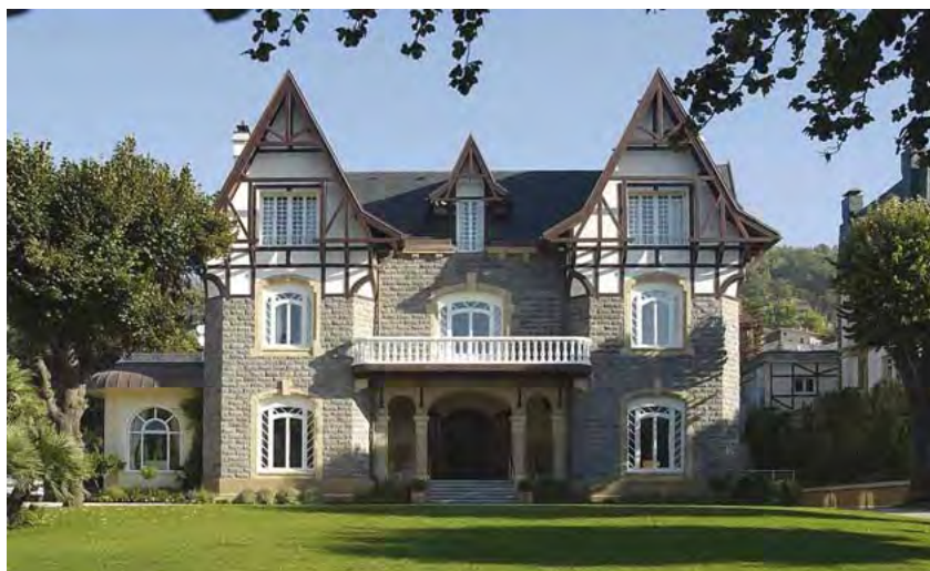
Fachada Hotel Villa Soro
