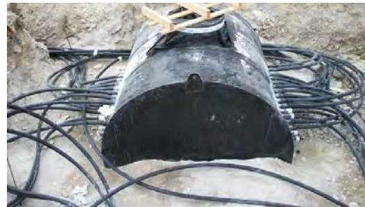
Arqueta de colectores
