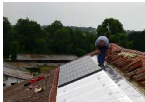
Montaje de la instalación
