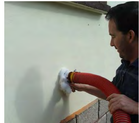
Detalle inyección celulosa en fachada
