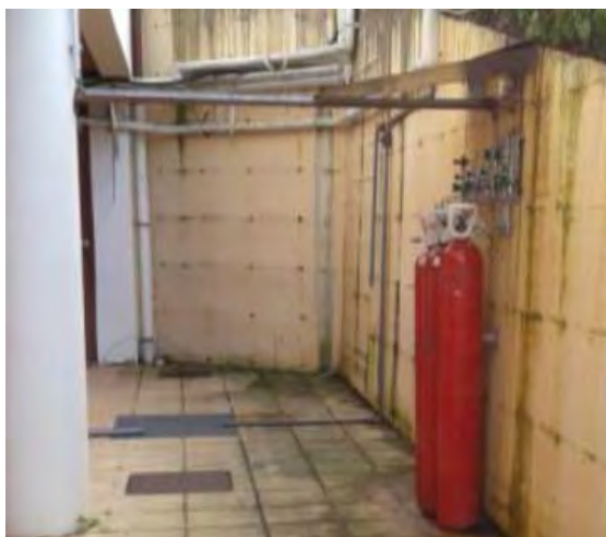
Instalación pila de hidrógeno
