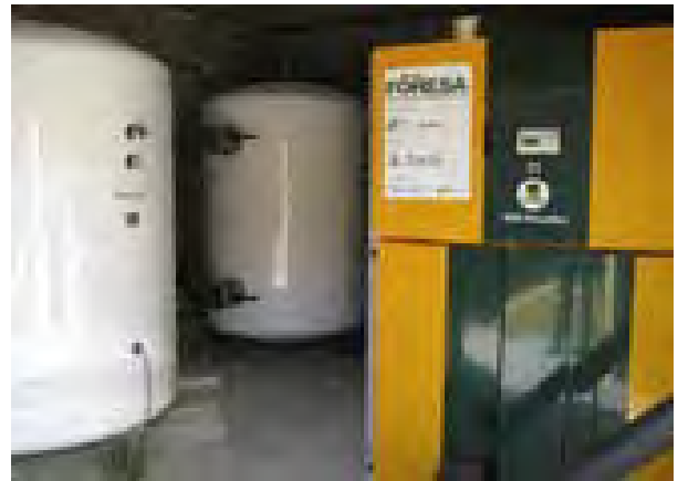
Caldera de biomasa similar a la que puede utilizarse en los edificios municipales de Asparrena 300kW
