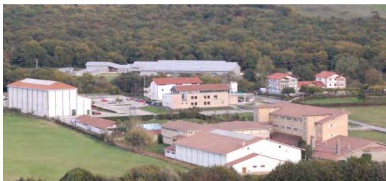
Vista de los edificios conectados con calefacción central
