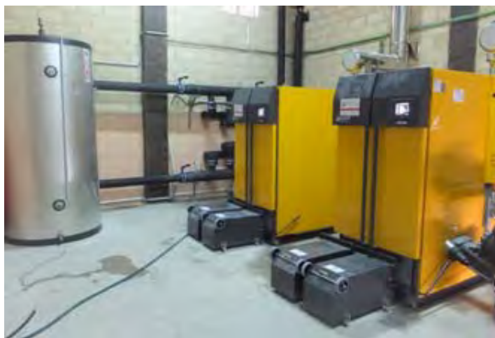
Sala de calderas centralizada para todo el pueblo
