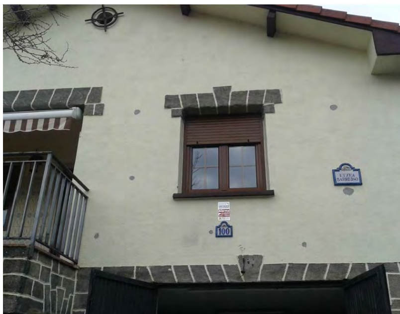
En la fachada, se observan los orificios en la envolvente de la vivienda
