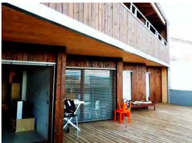
Vista fachada sur
