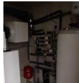
Climatización por aerotermia
