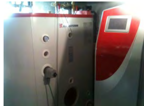
Depósito inercia y caldera biomasa
