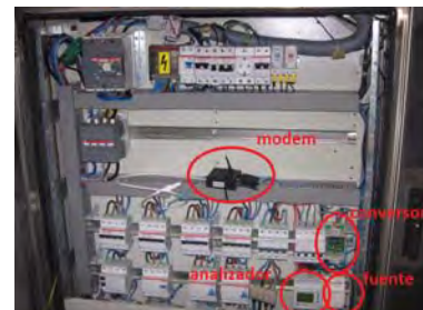
Analizadores de energía eléctrica en cuadro
